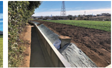
土砂流出防止対策/都筑区
