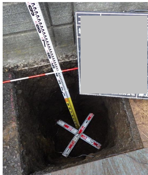
鋼管ポール設置工事の様子
