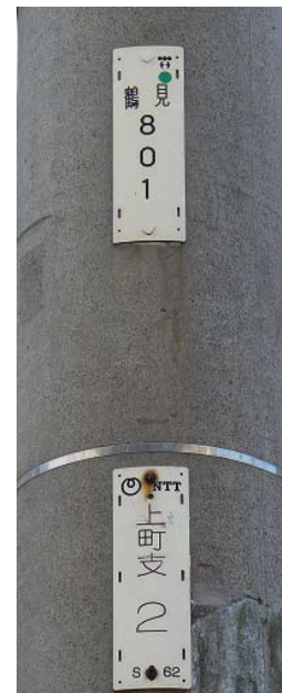
東京電力も使用しているNTT柱
