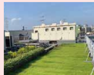
病院屋上での緑化整備(鶴見区)
