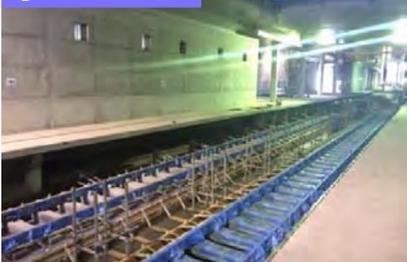
地下のホーム部はコンクリート構造物の工事が完了し、レールの敷設を進めています。地上では、駅舎の一部である電気室の建設が始まっています。
