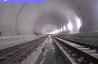
トンネル本体の工事が完了し、設備の工事を行っています。レールの敷設が進んでいます。
