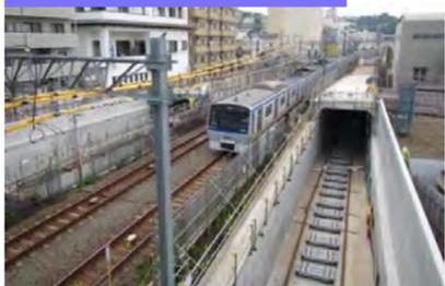
西谷駅付近から地下へと続くコンクリート構造物が完成し、レールの敷設が始まっています。
