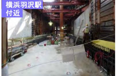
駅構内の線路を工事桁や鉄骨で仮受けし、地下から地上につながるコンクリート構造物を作っています。
