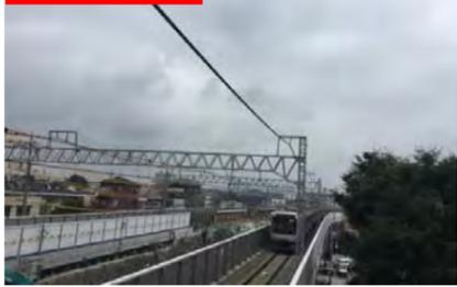
東横線を左右両側に新設した高架橋に切り替え、東横線が走行していた中央部の盛土の掘削を進めています。
