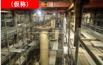
環状2号線の下で駅の工事を進めています。写真は鋼管柱を建てている様子です。
