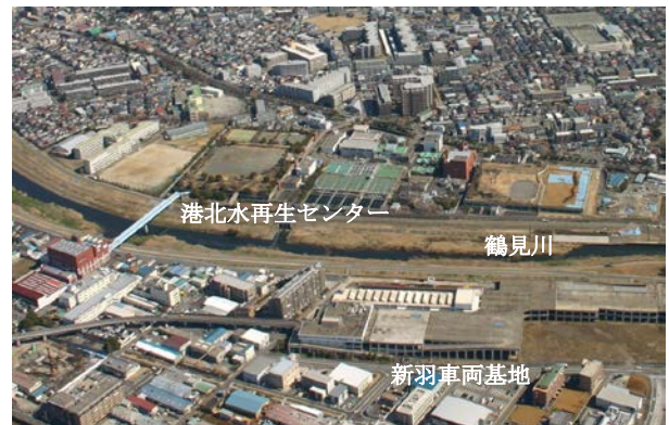
▲港北水再生センターと鶴見川(航空写真)
