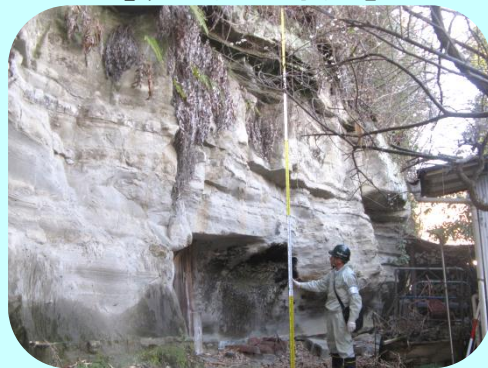
【現地調査の様子】
