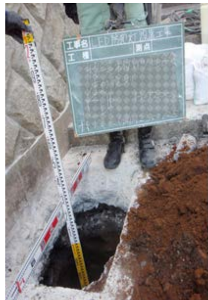
鋼管ポール設置工事の様子
