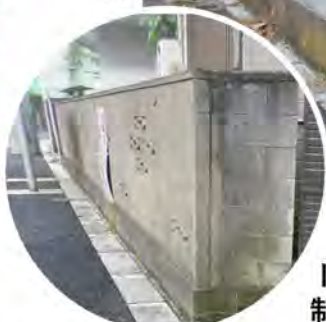
▼従前のブロック塀
