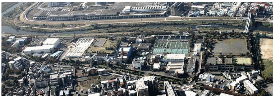
▲港北水再生センターと鶴見川(航空写真)
