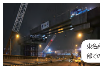
次々と建ち並ぶ橋脚
