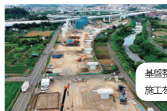
橋脚の土台部分の建設に着手
