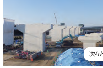
基盤整備を終え橋脚の施工を進めている様子
