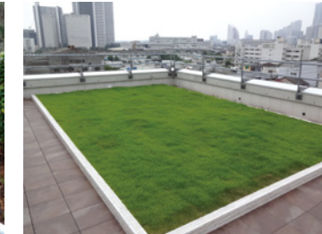
屋上緑化の事例(神奈川区)
